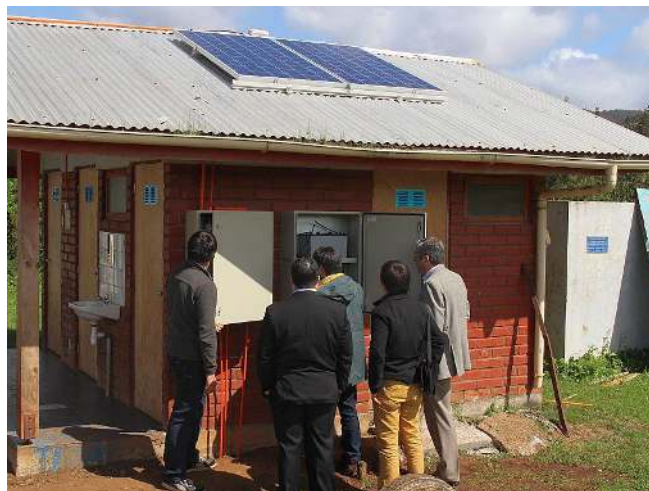
Figura 37: Sistema solar fotovoltaico de la escuela rural de Chol-Chol
